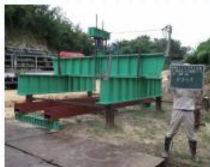
写真1 載荷装置組み立て
